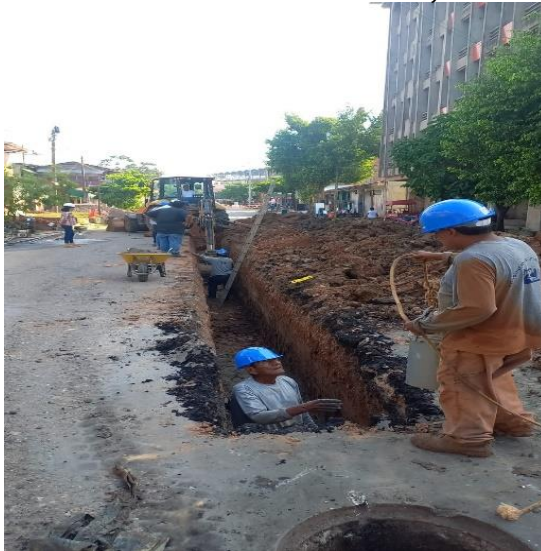
Foto N° 03: Excavación de Zanja
