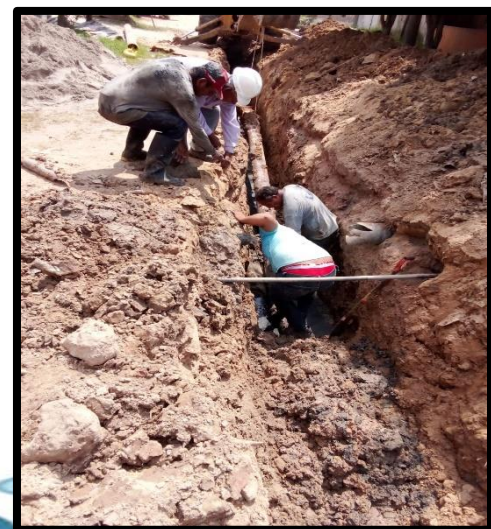
Foto N° 06: Colocación de Tubería
