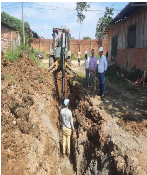
Foto N° 01: Excavación de Zanja
