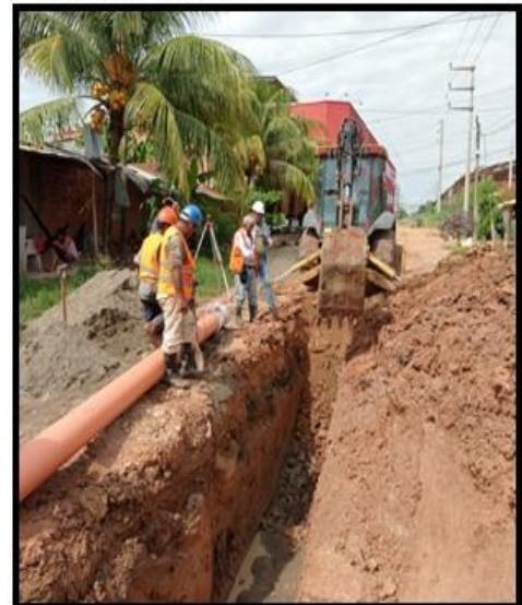
Foto N° 08: Excavación de Zanja
