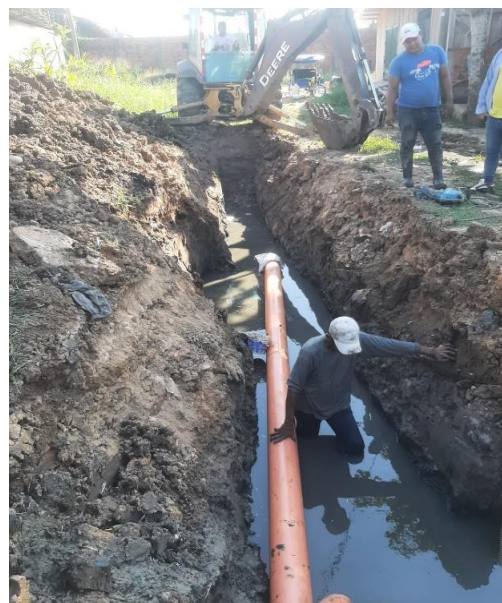
Foto N° 02: Cambio de Tubería
