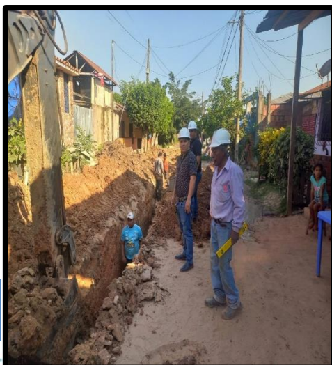
Foto N° 05: Excavación de Zanja
