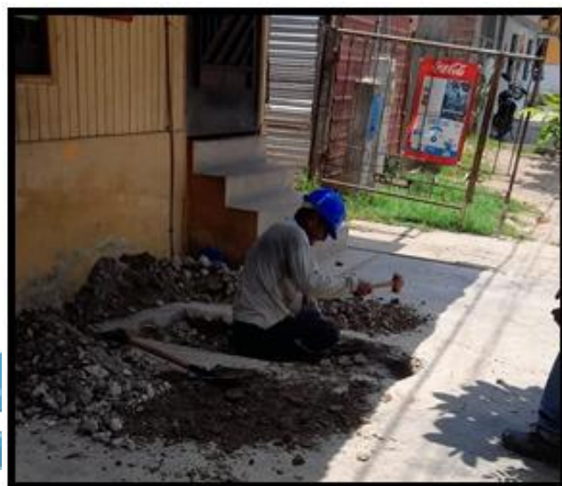
Foto N° 09: Instalación de conexión domiciliaria
